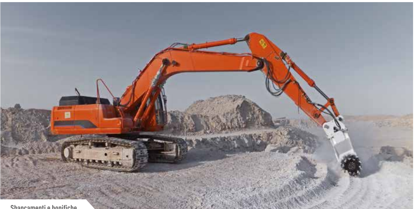
Sbancamenti e bonifiche
