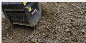
RECUPERO SCARTI DA DEMOLIZIONE
