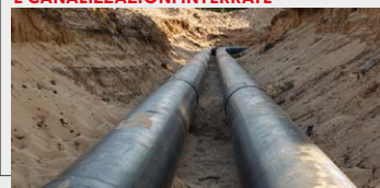
COPERTURA SOTTOSERVIZI E CANALIZZAZIONI INTERRATE
