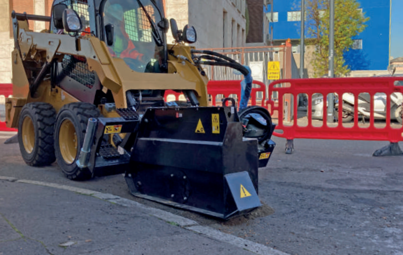
T 300. Schaffung des Mikrograbens mit einer 25 mm breiten Scheibe.
