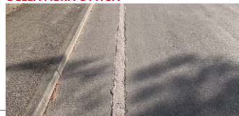
RIPRISTINI DOPO LA POSA DELLA FIBRA OTTICA
