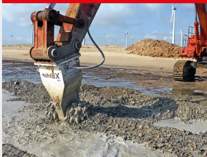
LAVORI IN IMMERSIONE
