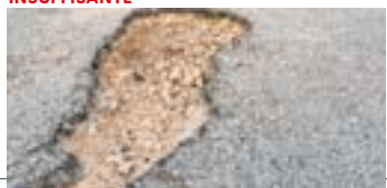
ROUTES AVEC UNE ÉPAISSEUR D'ENROBÉ INSUFFISANTE
