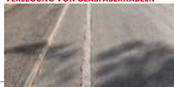
INSTANDSETZUNGEN NACH DER VERLEGUNG VON GLASFASERKABELN
