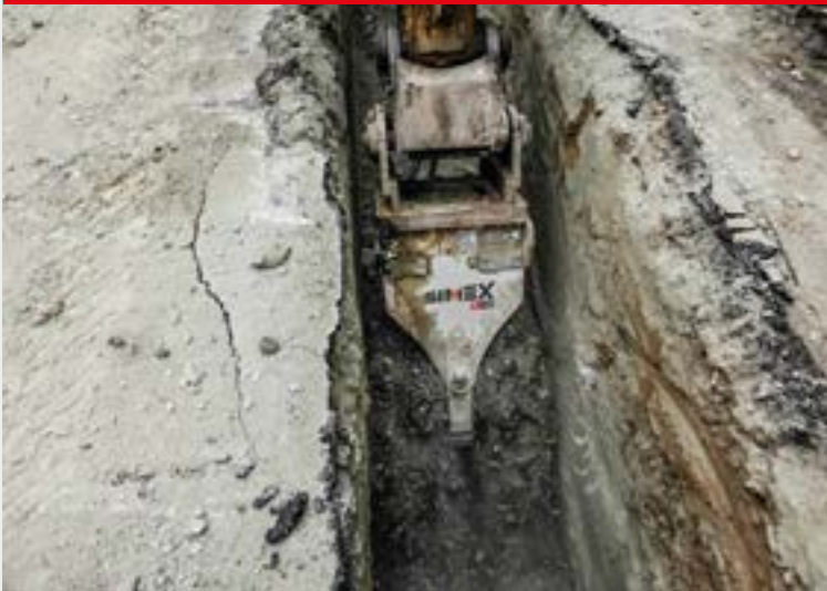
ZANJA DE SECCIÓN REDUCIDA
