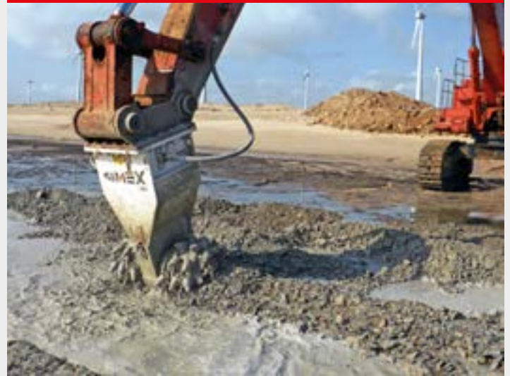
TRABAJOS EN INMERSIÓN
