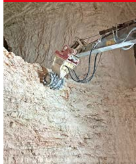
OBRAS EN CANTERA
